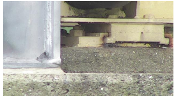
水管橋台座部分
